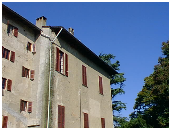
foto 2: è visibile la collocazione del microfono rispetto alla parete dell'edificio
